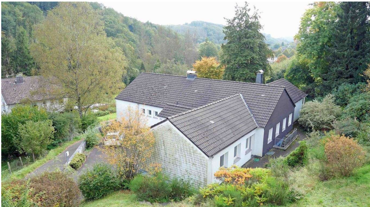
das Dach wurde 1993 erneuert und gedämmt
